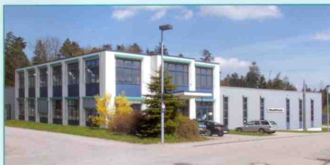
MultiFinish–производственный цех и административное здание в Шёмберг-Лангенбране рядом с Пфорцгеймом (Германия)
